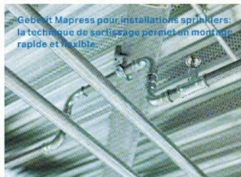
Geberit Mapress pour installations sprinklers: la technique de sertissage permet un montage rapide et flexible.
